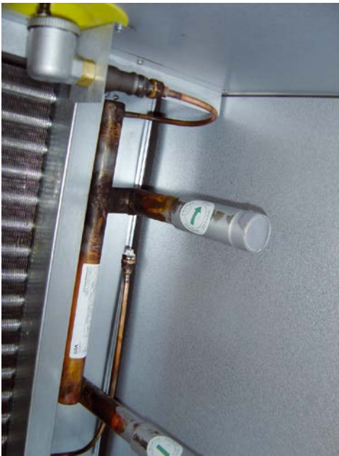
Le raccordement interne de la batterie d'une centrale extérieure permet le placement de la pompe et de la robinetterie à l'abri du gel
