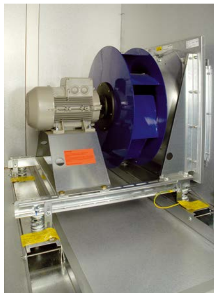
Châssis commun pour l'unité moto-ventilateur
