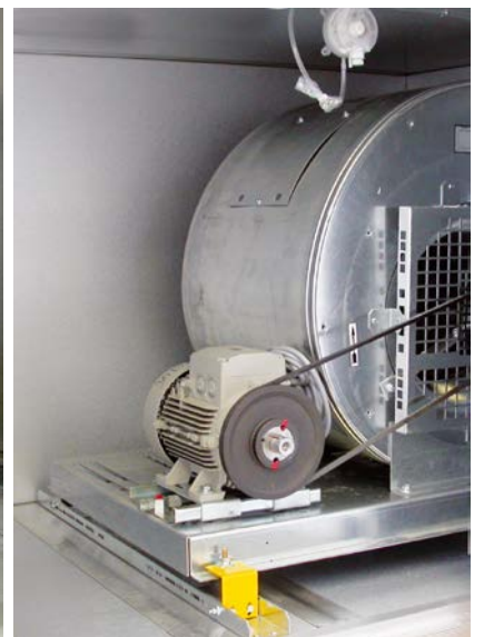
Châssis commun pour l'unité moto-ventilateur
